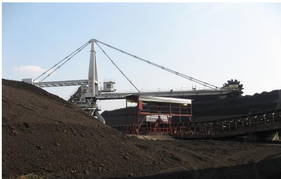
Рисунок 2.5 – Угольный склад на ТЭС
